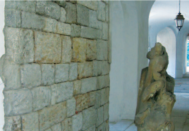
Stuttgart melletti Solitude kastély: A nedvesség által jelentősen károsodott falfelületek felújítása
